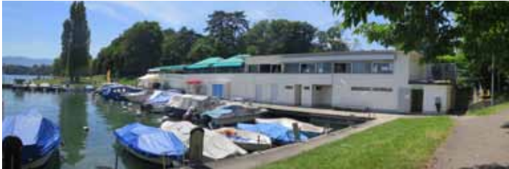
Vue du rez-inférieur (est). Bien qu'ayant subi des ajouts malheureux, la bâtiment possède encore une belle qualité architecturale caractéristique de son époque de construction.
