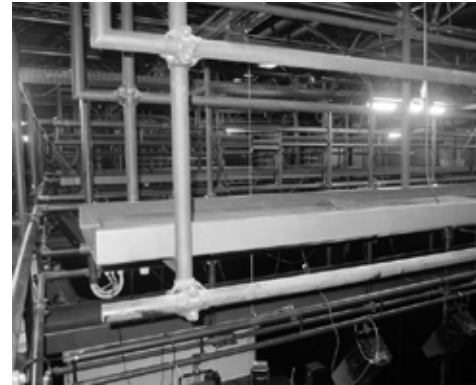
Théâtre du Grütli / Genève. Grill et réseau de passerelles, au-dessus de la salle et du plateau.
