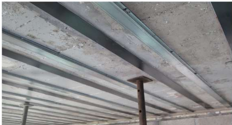
Rez-inférieur > Restauration des locaux > Renfort structurel avant pose placo-plâtre
