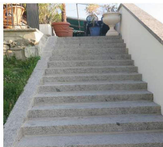
Escalier > Adaptation marches, nouveaux joints, peinture ext.
