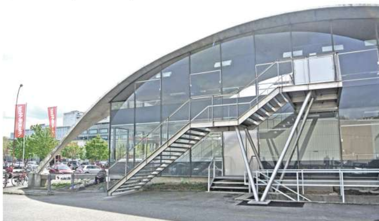
Ajout d'un escalier extérieur pour des questions de sécurité et norme AEAI
