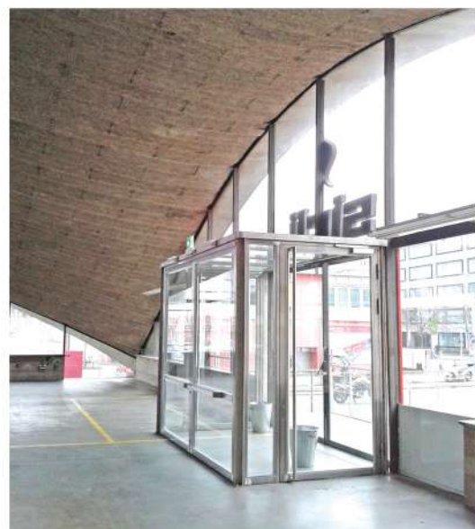
Création d'un sas d'entrée, pour des questions thermiques
