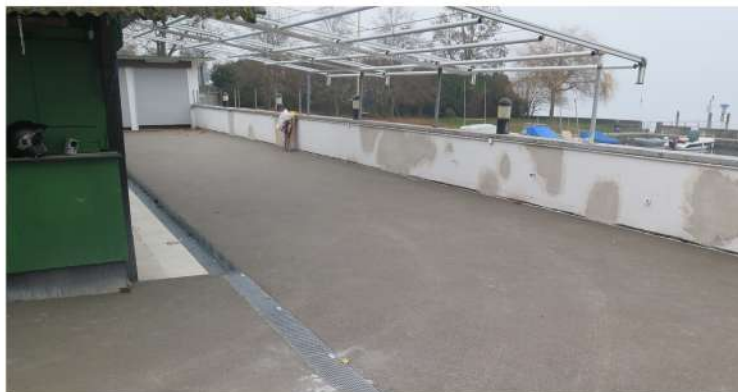
Vue de la terrasse > Renfort structure, étanchéité, asphalte, résine PMMA (aspect minéral)
